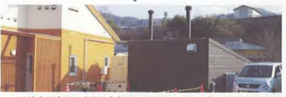
徳島県吉野川さくら診療所に導入されたチップボイラー(写真②)
